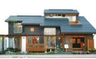
エアムープ住宅 木造軸組構法(エアムープ工法) TEL.027-237-0075
