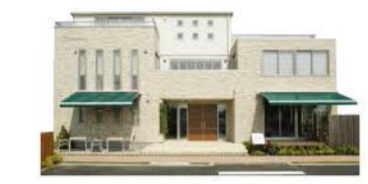
トヨタホーム北関東 鉄骨ラーメンユニット工法 TEL.0276-30-1200
